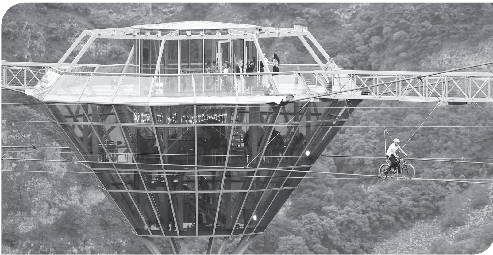
JEMBATAN KACA DI ATAS DASHBASHI CANYON - GEORGIA
